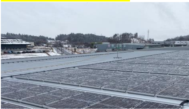
太陽光パネル設置工事完了
